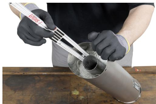
Placez l'embout sur le silencieux de manière à ce que le tube perforé soit correctement inséré dans la base et les alésages pour les rivets soient realignés. Pour cela, servez-vous des traits préalablement marqués par vos soins. Alignez les alésages l'un sur l'autre avec précision, enfoncez des rivets aveugles étanches aux gaz d'un diamètre approprié dans les trous et serrez-les à l'aide d'une pince à rivets aveugles, de manière à ce que le fil métallique des rivets se sectionne.
